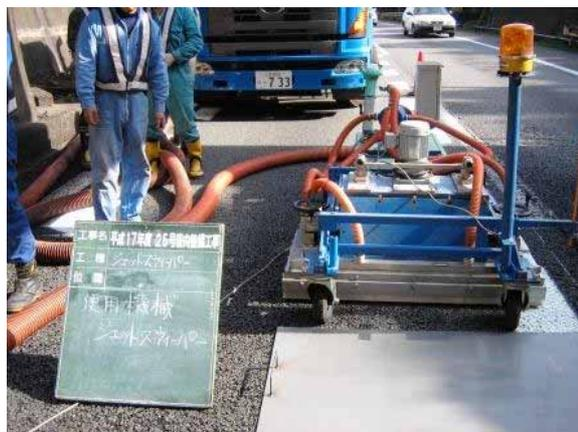
写真 - 3 ジェットスリーパ装置の概観
