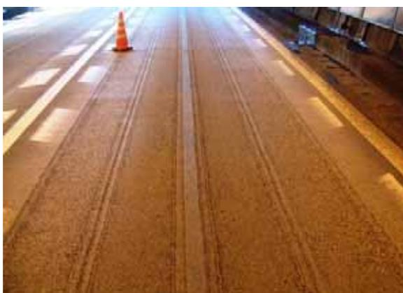
写真 - 4 処理後のコンクリート舗装面
